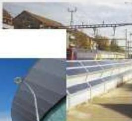
Moduli fotovoltaici come barriere antirumore lungo arterie stradali a scorrimento veloce, Ferrovia di Wädswiler in Svizzera.
