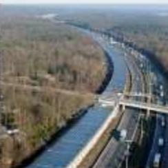
Tunnel ferroviario fotovoltaico lungo 3,6 km in Belgio: 16.000 pannelli solari. Producibilità pari a 3.300 MWh.
