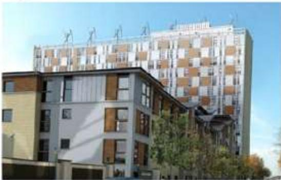
Diverse applicazioni di mini eolico con turbine ad asse verticale e logica elica (modello Quirevolution QPC altezza 5m e diametro 3m, modello QP12 altezza 12m e diametro 6m) utilizzabile anche in contesti urbani sul tetto di un edificio residenziale, per la pubblica illuminazione degli spazi condominiali, per insegne pubblicitarie, in
