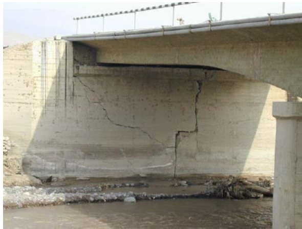
DANNEGGIAMENTO SPALLA
