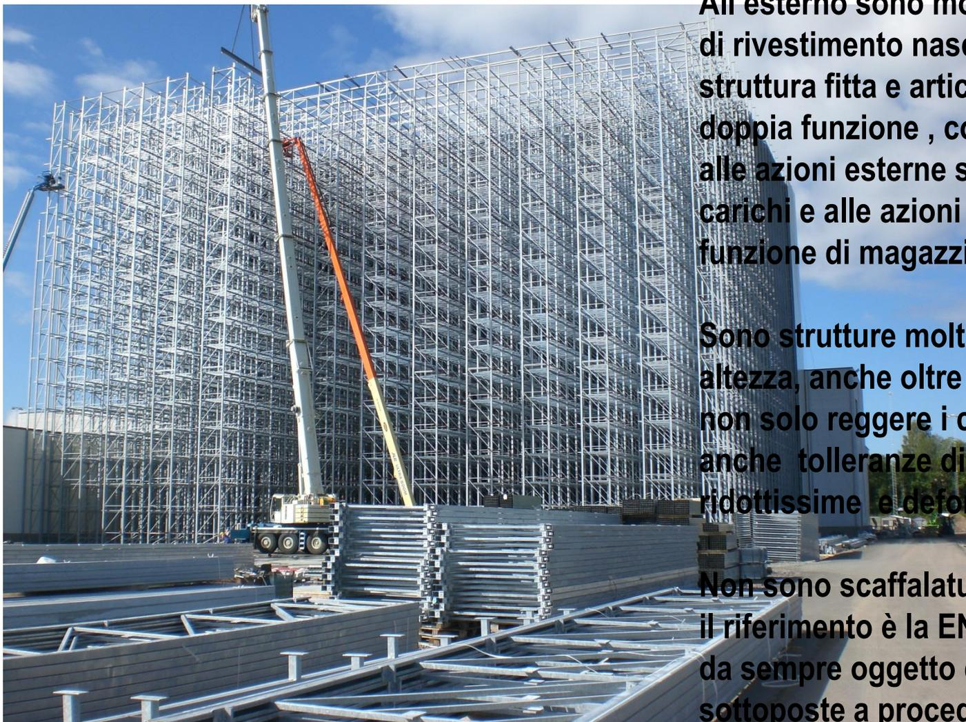
**All'esterno sono molto puliti, i pannelli di rivestimento nascondono una struttura fitta e articolata che ha una doppia funzione, con riferimento sia alle azioni esterne sull'edificio, sia ai carichi e alle azioni derivanti dalla funzione di magazzino.**
